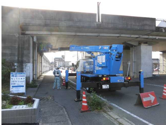
橋梁点検車による点検
