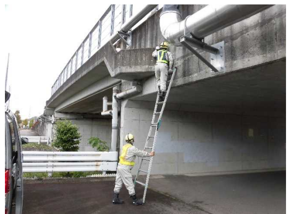
近接目視点検の状況
