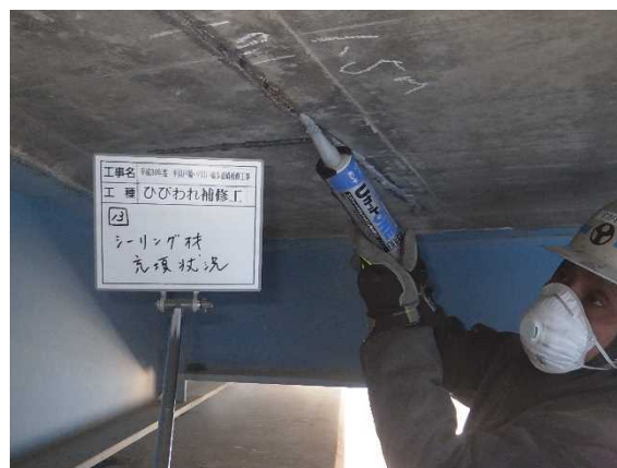
シーリング材充填
