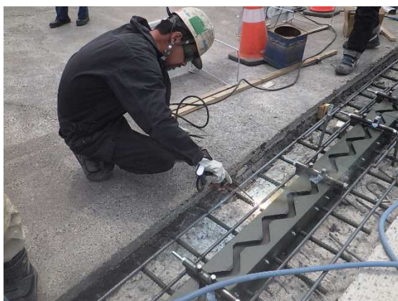
伸縮装置取り付け
