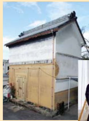
【左】三階倉(壁面保護前)
