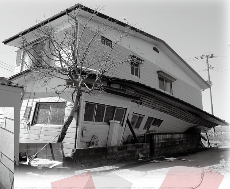
東日本大震災(平成23年3月・宮城県土木部提供)
