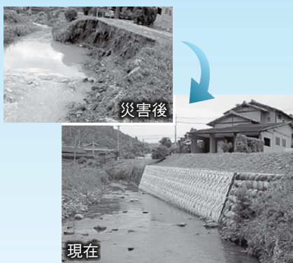
柿下川の護岸復旧工事(柿下)
