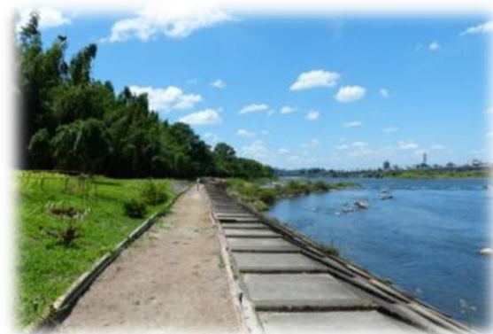
遊歩道（河川管理用通路）の整備
