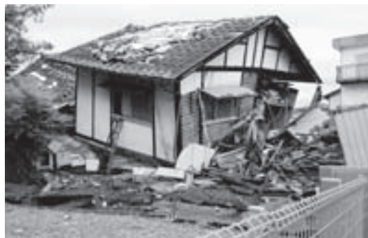
平成 28 年熊本地震の被災建物（可児市派遣職員撮影）
