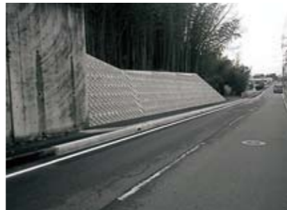
整備後の道路
