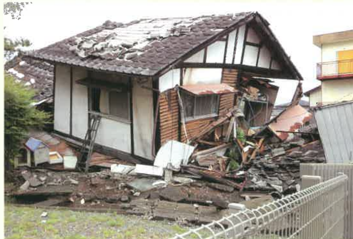
住宅(木造)の倒壊
