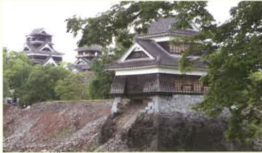
熊本城の石垣の崩壊
