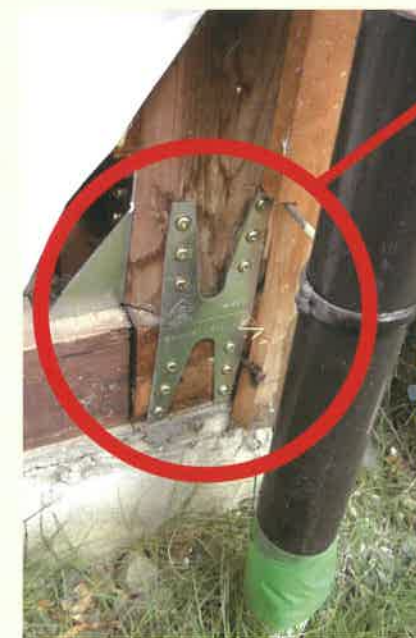
柱脚と土台に専用金物を新たに設置し改修した状況
