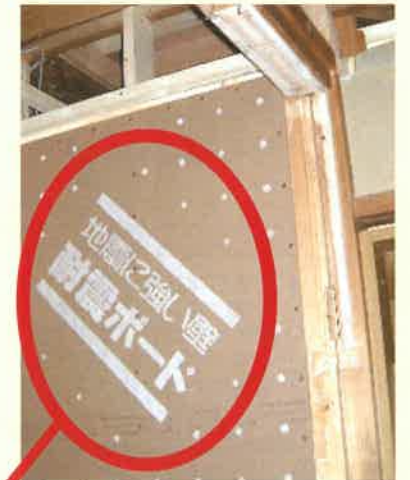
壁に構造用合板を新たに設置し改修した状況
