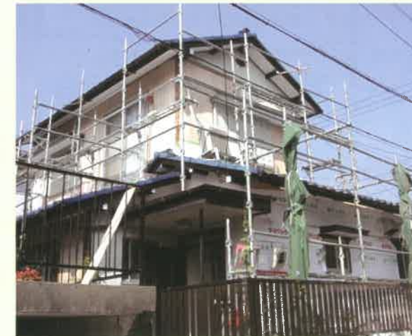
耐震改修工事現場の外観状況
