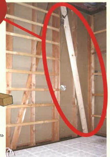
右側の壁に新たに筋かいを設置し改修した状況
