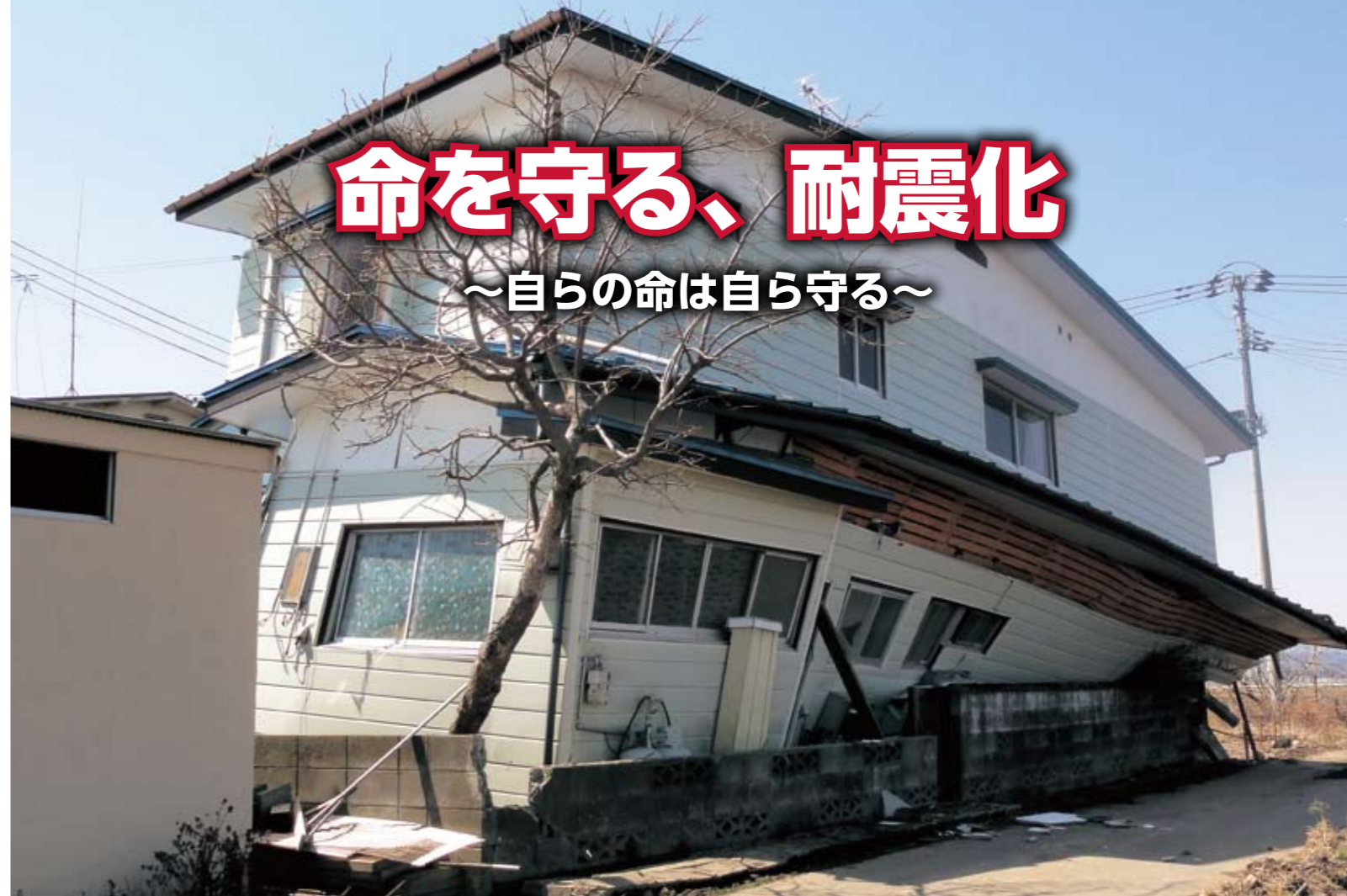
東日本大震災（平成 23 年 3 月・宮城県土木部提供）
