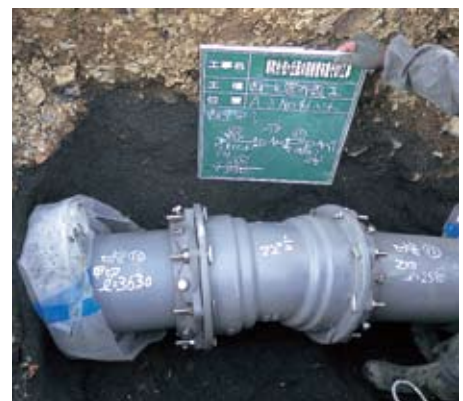
耐震管の布設替工事
