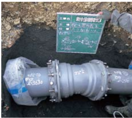
耐震管の布設替工事
