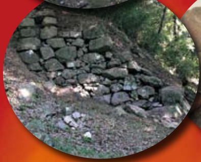
二の丸西面石垣
