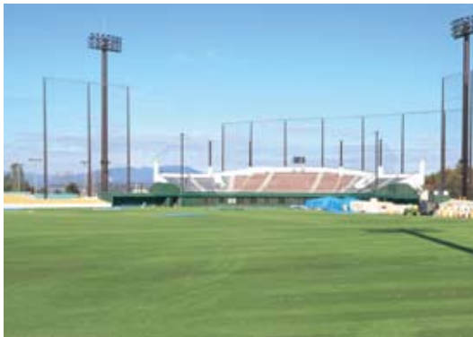
運動公園スタジアム（建設中）
