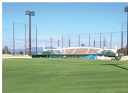
運動公園スタジアム(建設中)
