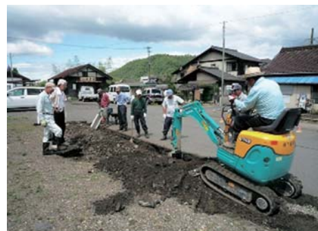
土壌整備の様子
