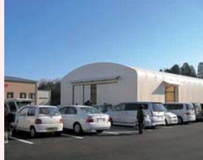
エコドームの外観
