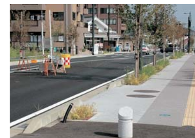
可児駅東地区の歩道整備
