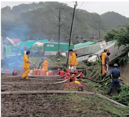
消防団が夜を徹して市道の排水作業をする様子
