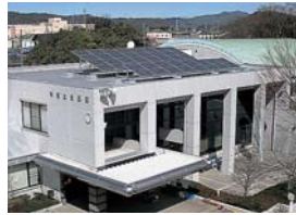
中恵土公民館に設置された太陽光発電装置
