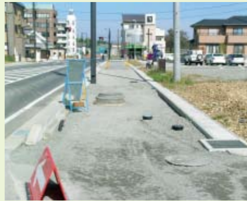
整備が進む可児駅東地区
