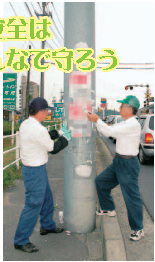
簡易除却の様子
