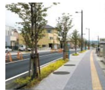
可児駅東地区の歩道整備
