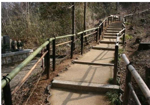
荒川豊蔵資料館通路に設置された手すり
