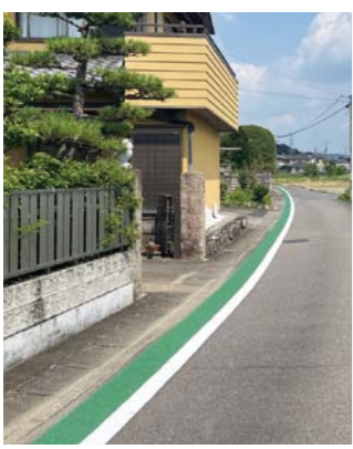
カラー舗装の例
