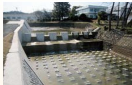
改修後の河川。大雨による氾濫を防ぐため、川幅を従来の倍に広げました。川底に設置した河床ブロックには、土砂の流出を抑える効果があります。
