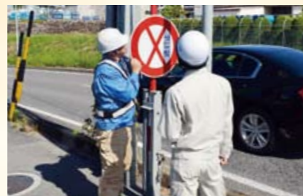
道路の冠水時に車が進入しないようにする標識の動作確認
