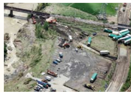
平成22年の豪雨災害による土田地内の様子(国際航業株提供)
