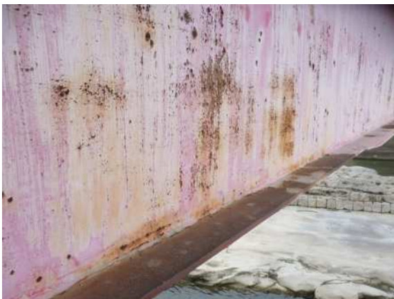
鋼橋の桁錆
